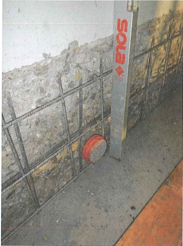
Einbau der Korrosions- und Feuchtesensoren anlässlich einer Bauwerkssanierung. Foto: BS2 Sicherheitssysteme GmbH
